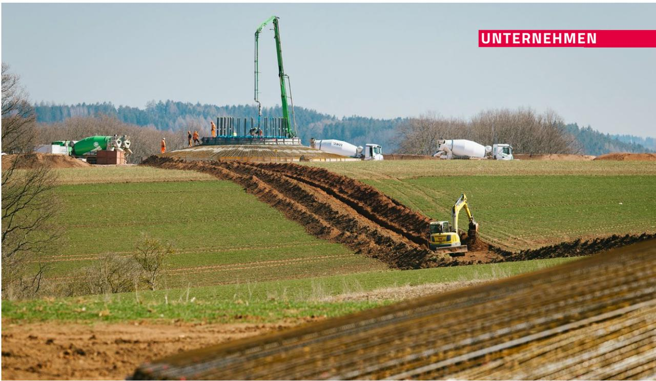
In den Gräben werden die Erdkabel verlegt, die den erzeugten Strom zum Umspannwerk des Parks leiten.
