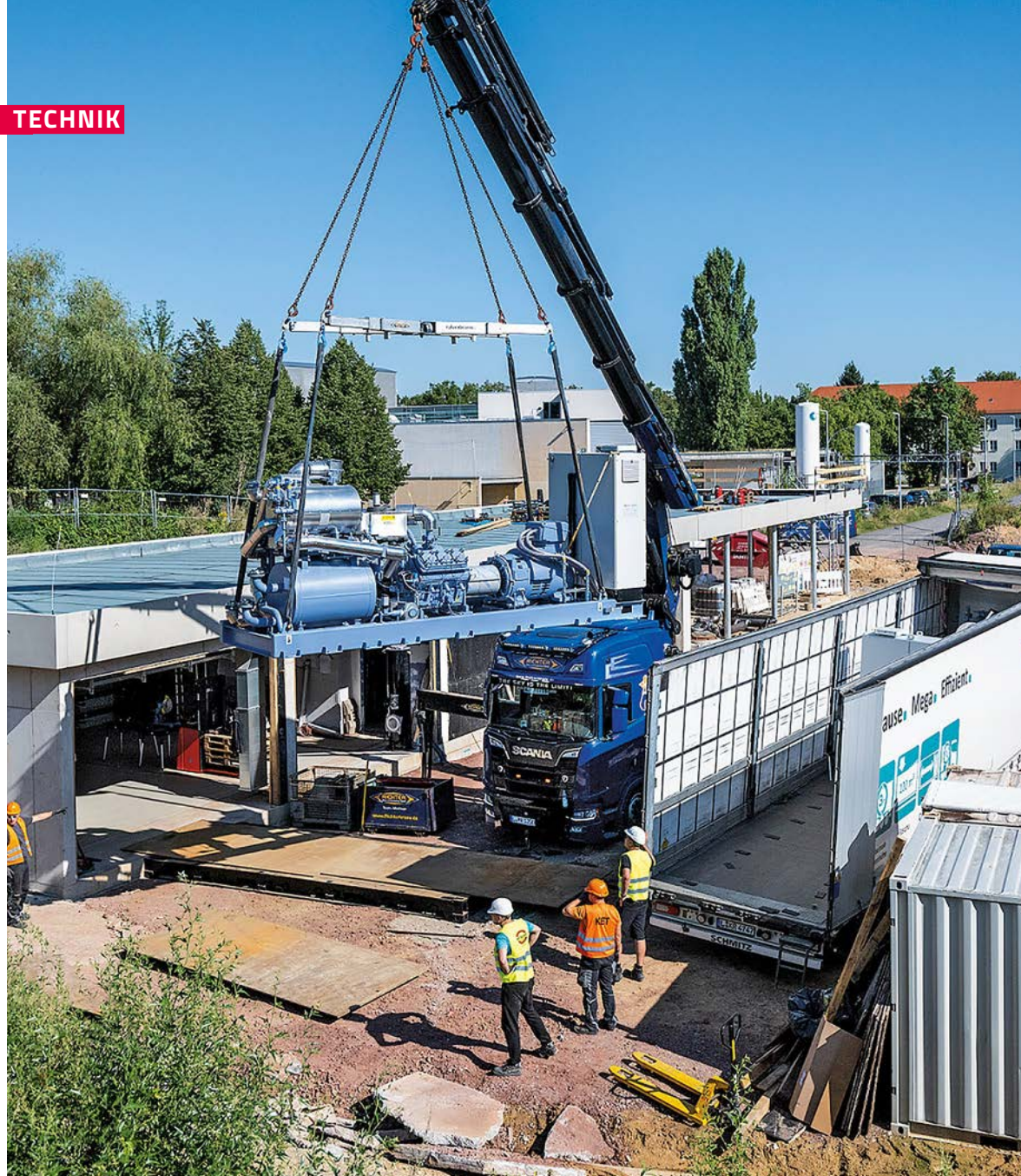
Ein Schwerlastkran hievt das neun Tonnen schwere Modul der Großwärmepumpe an ihren Standort auf dem Betriebsgelände der TU Dresden an der Nöthnitzer Straße
