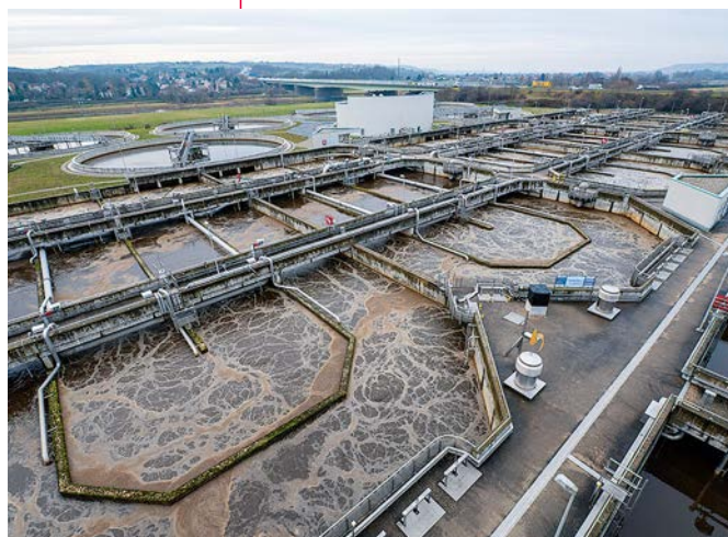
Die Belebungsbecken der Dresdner Kläranlage. Sie funktioniert wie ein Bioreaktor, in dem Mikroorganismen alle Stoffe zersetzen, die nicht im Wasser bleiben sollen
