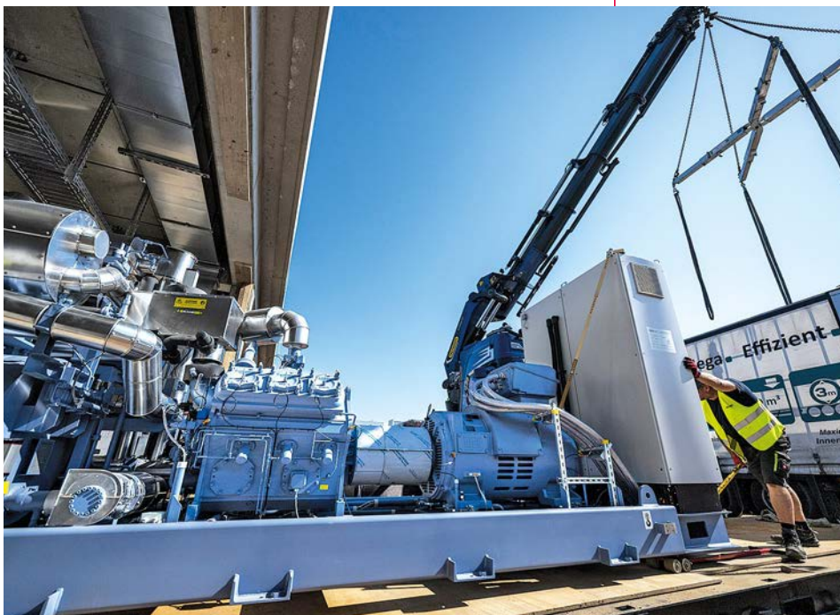
Eines der drei Module der Großwärmepumpe legt seine letzten Meter zurück. Fachleute von SachsenEnergie packen tatkräftig mit an
